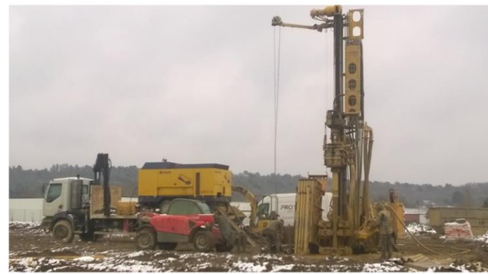
S06 - Forage du 1 er sur les 23 puits de géothermie (135m profondeur / 1 puit par jour)
