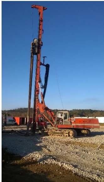
S05 - Forage de 250 inclusions pour renforcement du sol (3 à 5m profondeur / 0.5h par puit)
