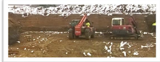
S06 - Creusement des 1 eres fondations au RDJ (Rez de Jardin)
